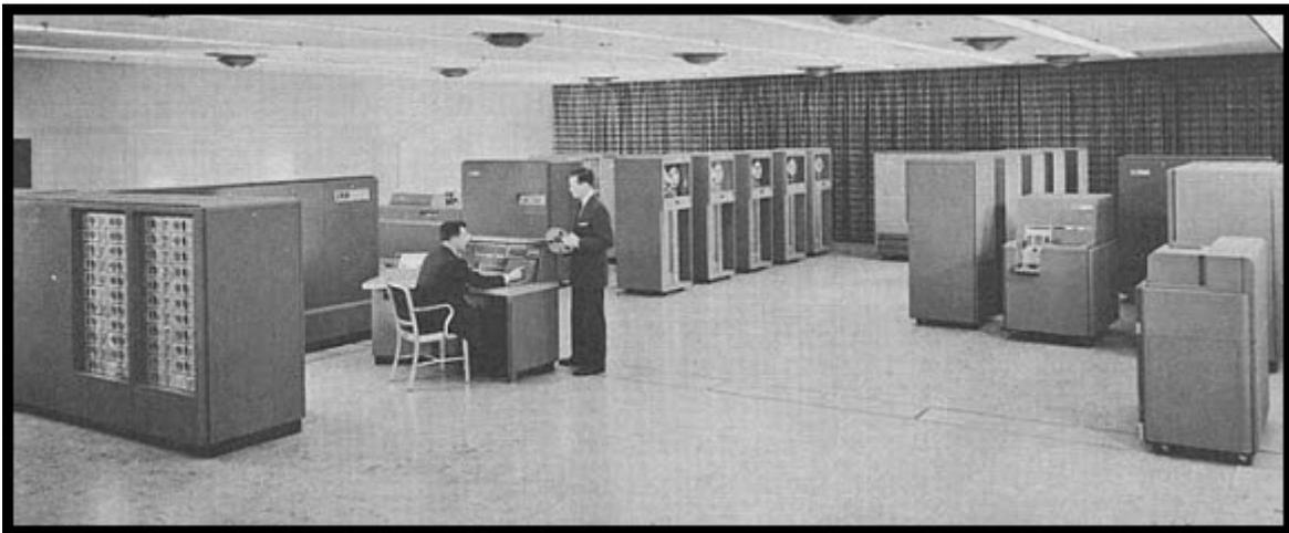
Figura 8. Instalación de un mainframe IBM 702 — Fuente: [Wikipedia](#)
