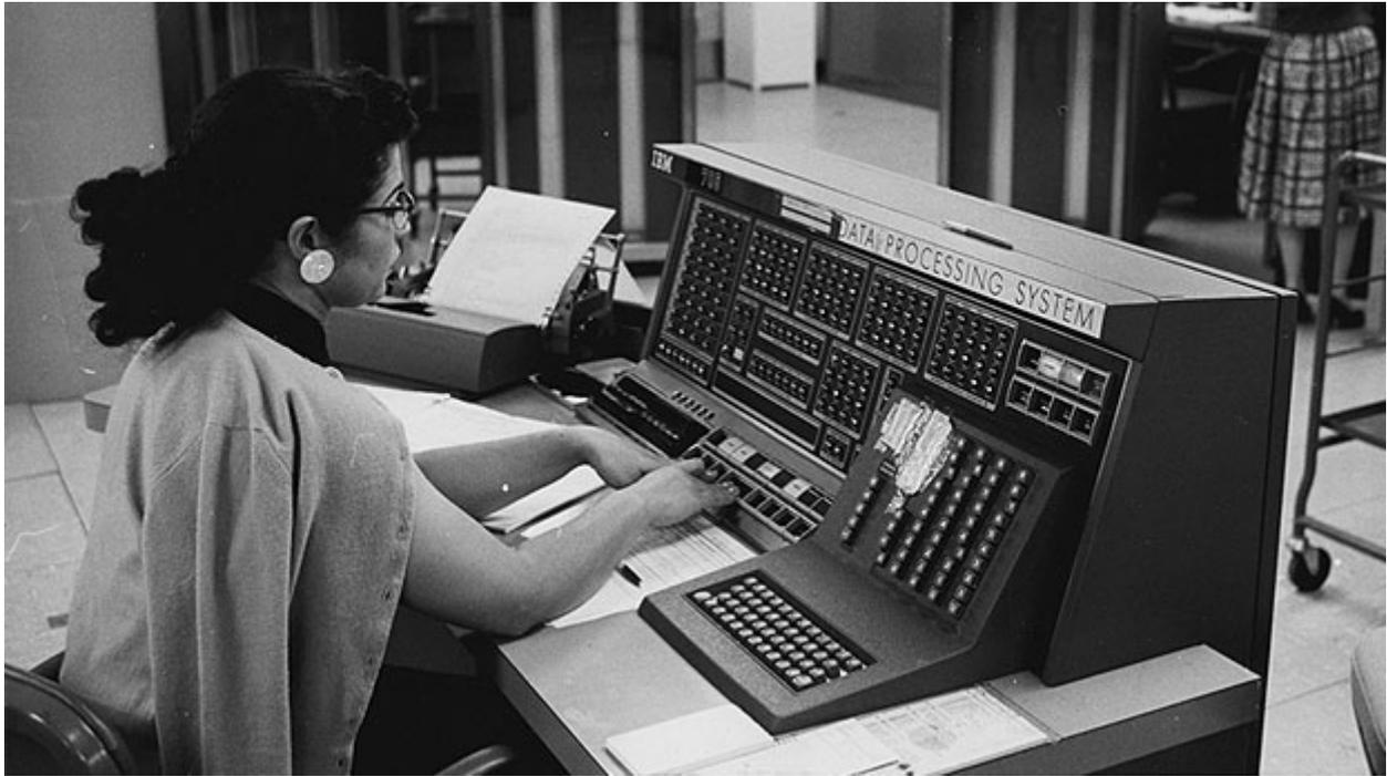
Figura 2. Operadora en la consola de un mainframe IBM 705 — Fuente: IBM
