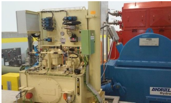
Un generador de la central hidroeléctrica Gorona del Viento
