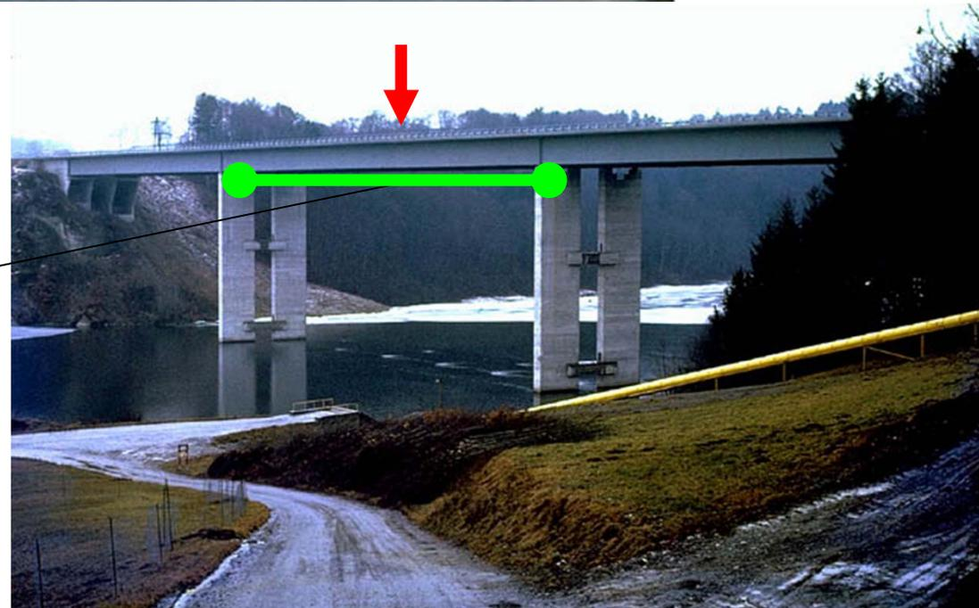
Puentes trabajando como estructuras de viga frente a una carga transversal
